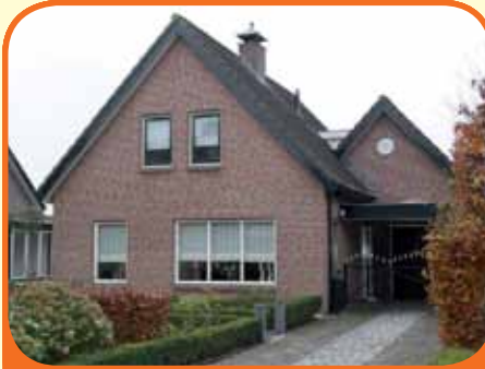
RAALTE, De Schouw 94
