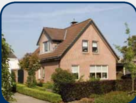
RAALTE, De Schouw 94
