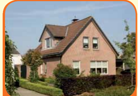
RAALTE, De Schouw 94
